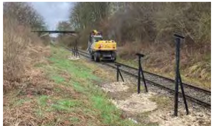
Het plaatsen van de steunen met behulp van de spookraan
